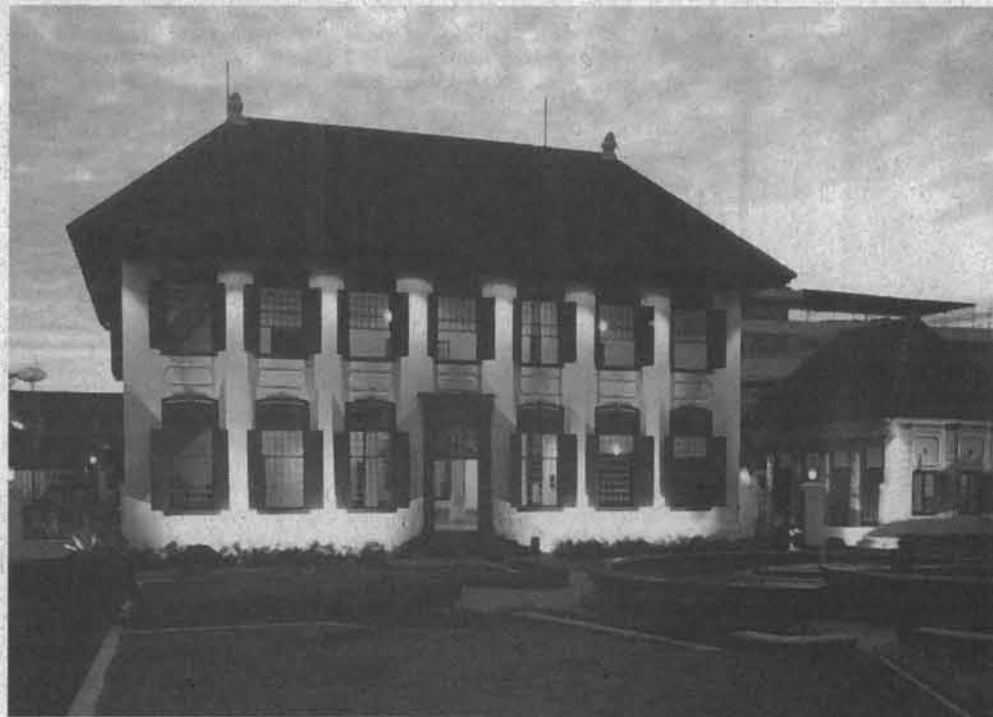
Gedung Arsip Nasional di Jalan Gajah Mada
