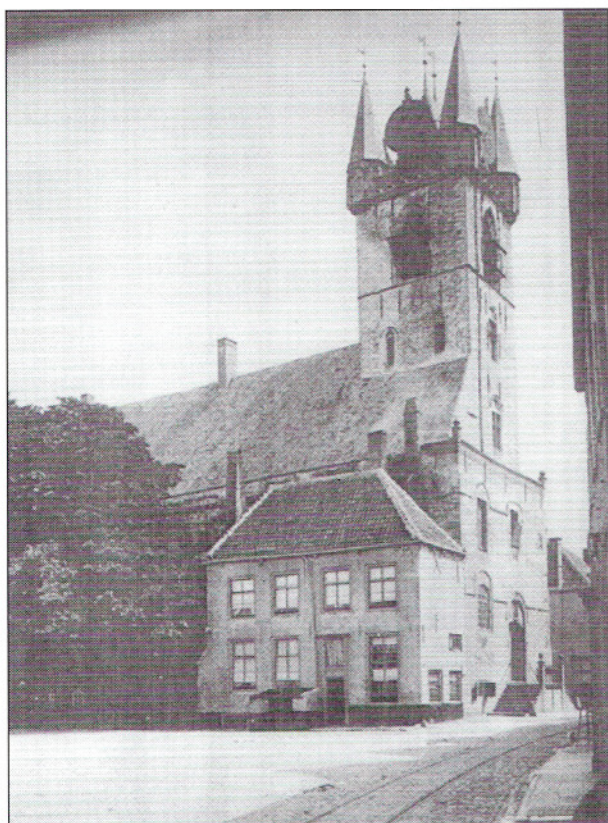
25 Sluis: Het gemeentehuis. Opgenomen vanuit het noordwesten.
