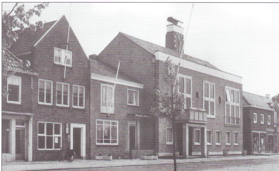
8 Schoondijke: Het raadhuis aan de brink (1955). Architect: ir. S.J. van Embden.
